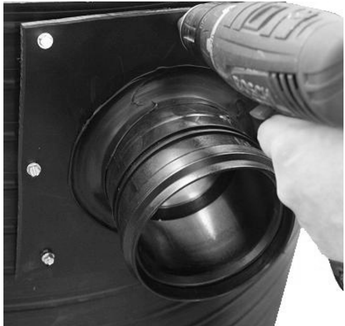
Kuva 4. Jälkiliittymäsatulan kiinnitys
