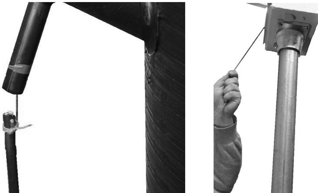
Kuva 2. Sähkökaapelin tuonti
